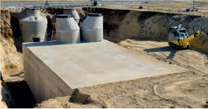
Rohbau des Beckens (September 2022)
