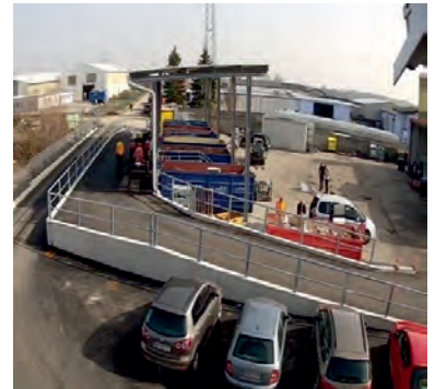
Containerrampe der Wertstoffhalle.
